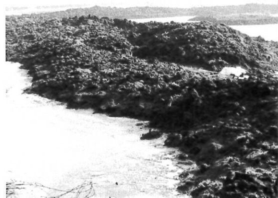
Rund eine Million Kubikmeter Erde mussten bewegt werden
