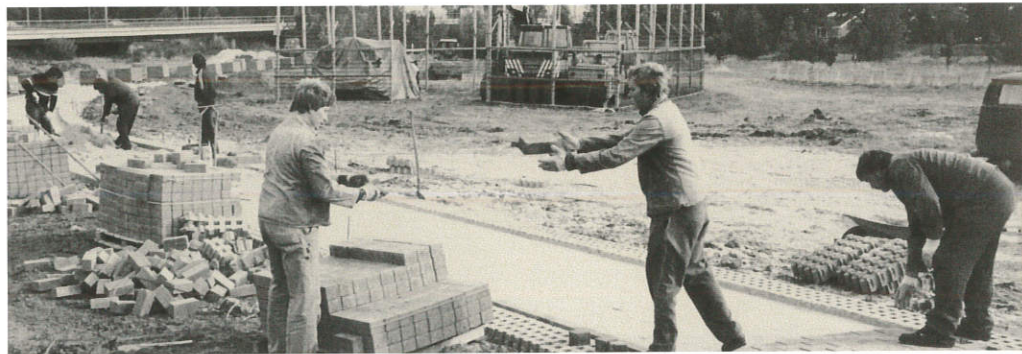
Bau des Achterfeldweges neben der neuen Kabeltrasse
