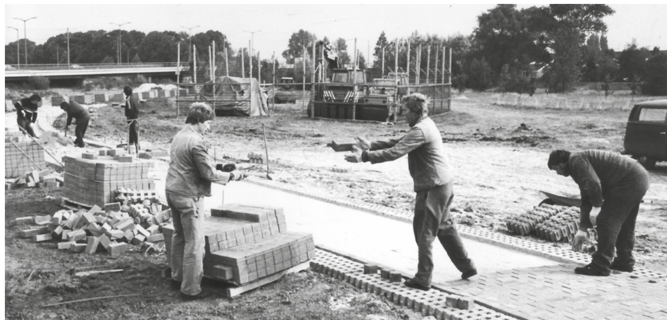
Bau des Achterfeldweges neben der neuen Kabeltrasse
